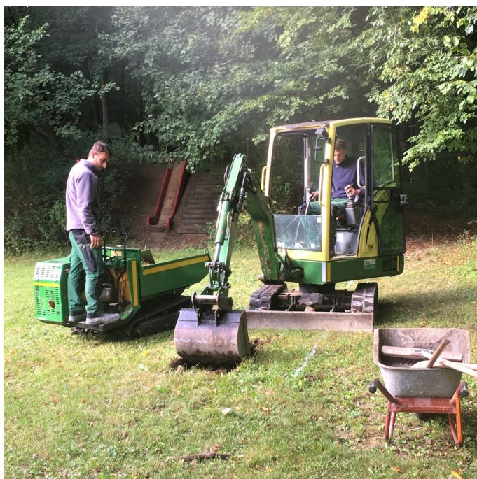
Der Barfußpfad wird in der Nord-Westecke des Spielplatzes ausgehoben
