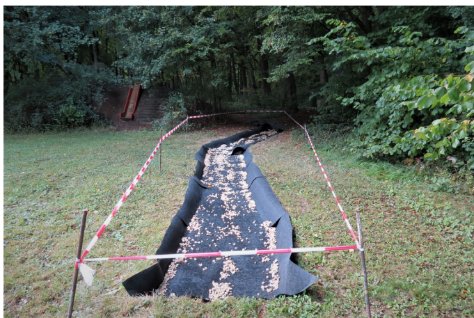
Das Fundament ist fertig
