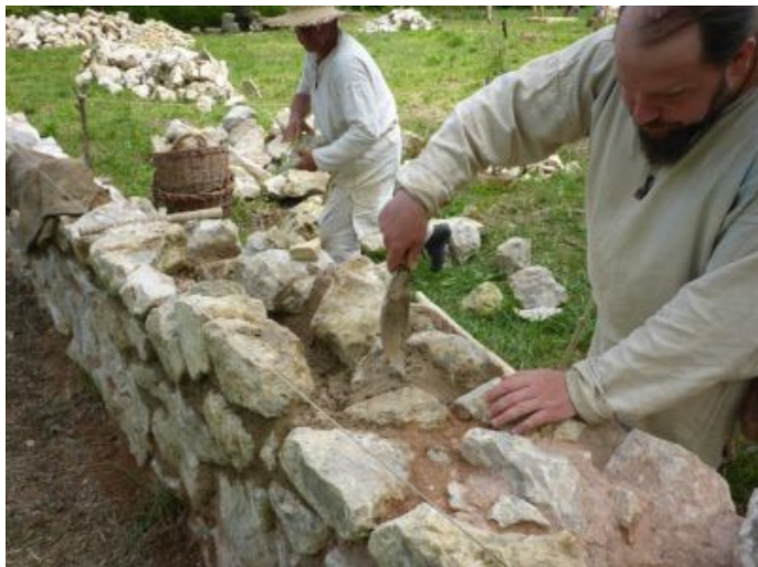
Errichtung der Obstgartenmauer
