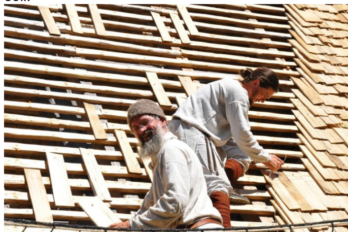
Dachdecken mit Holzschindeln
